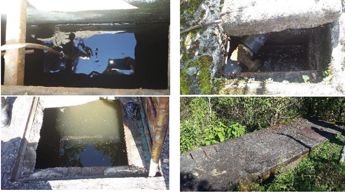
Figura 5.44. Tanque Desarenador Coordenadas N 6°7'25.8276" W75°36'10.998"
