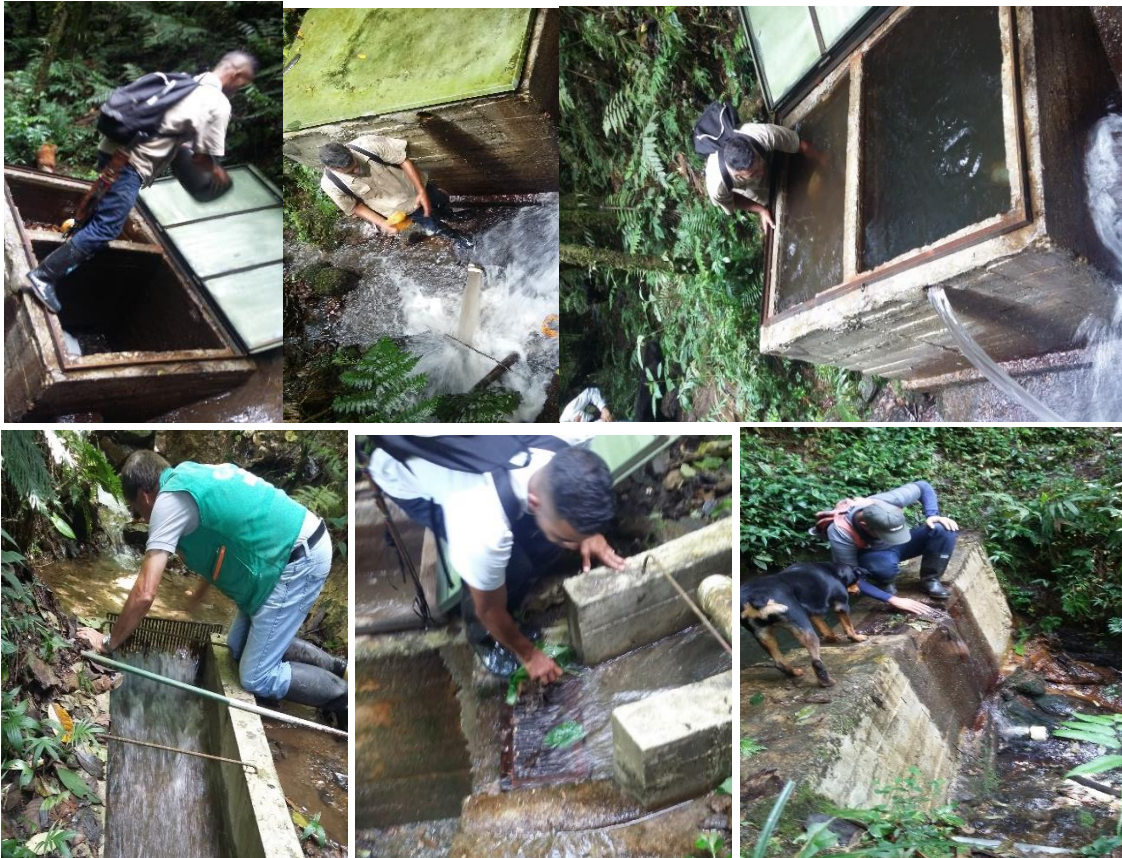
Figura 5.35. Mantenimiento del acueducto
