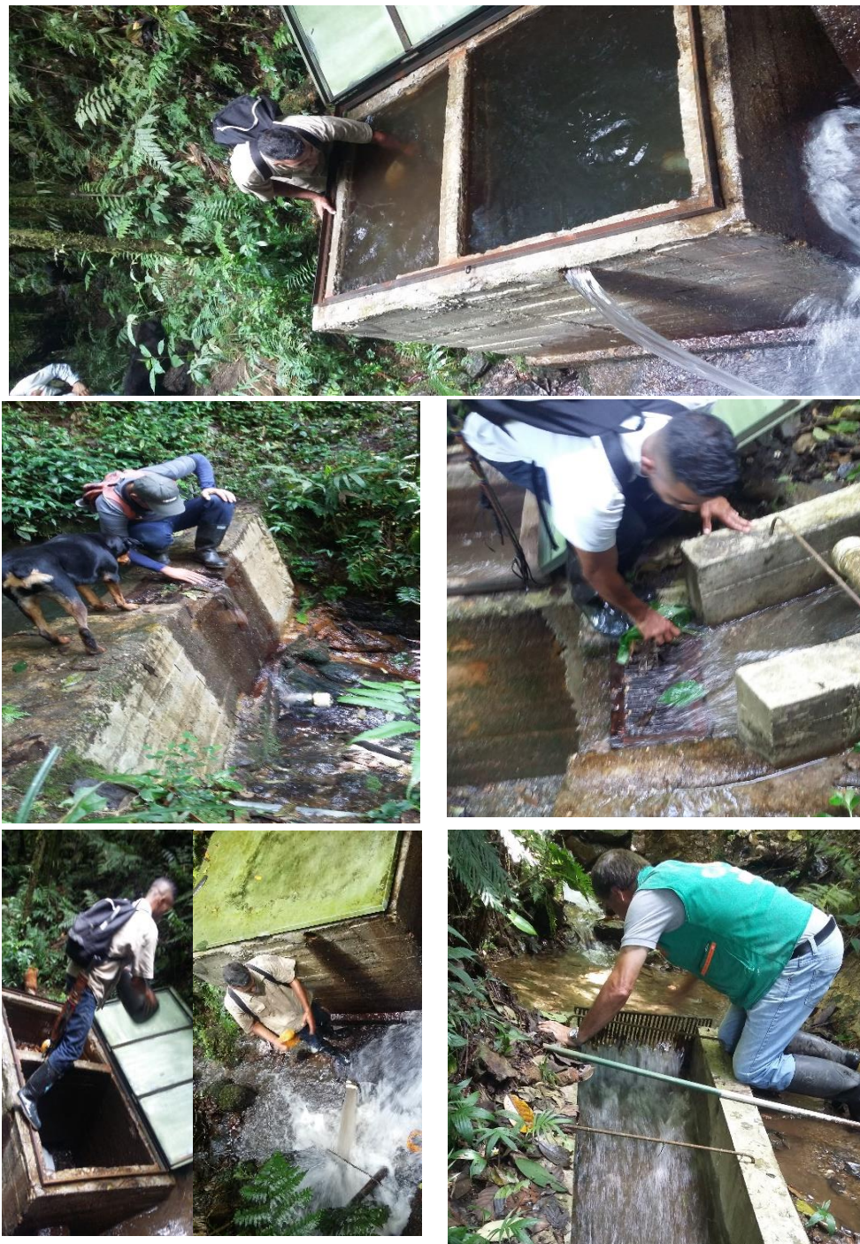
Figura 5.26. Mantenimiento del acueducto
