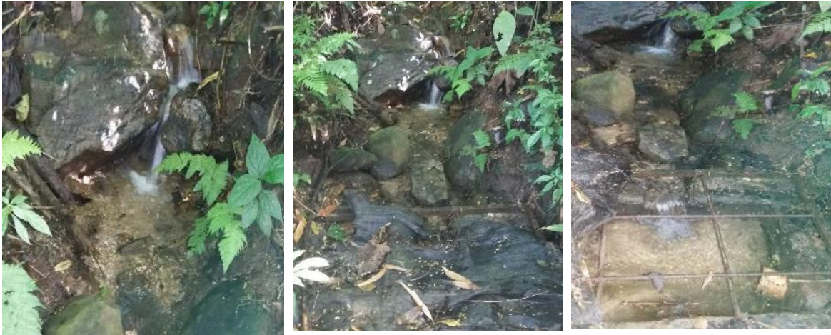
Figura 5.48. Bocatoma #2 N 6°8'27.3336" W 75°35'39.1452"
