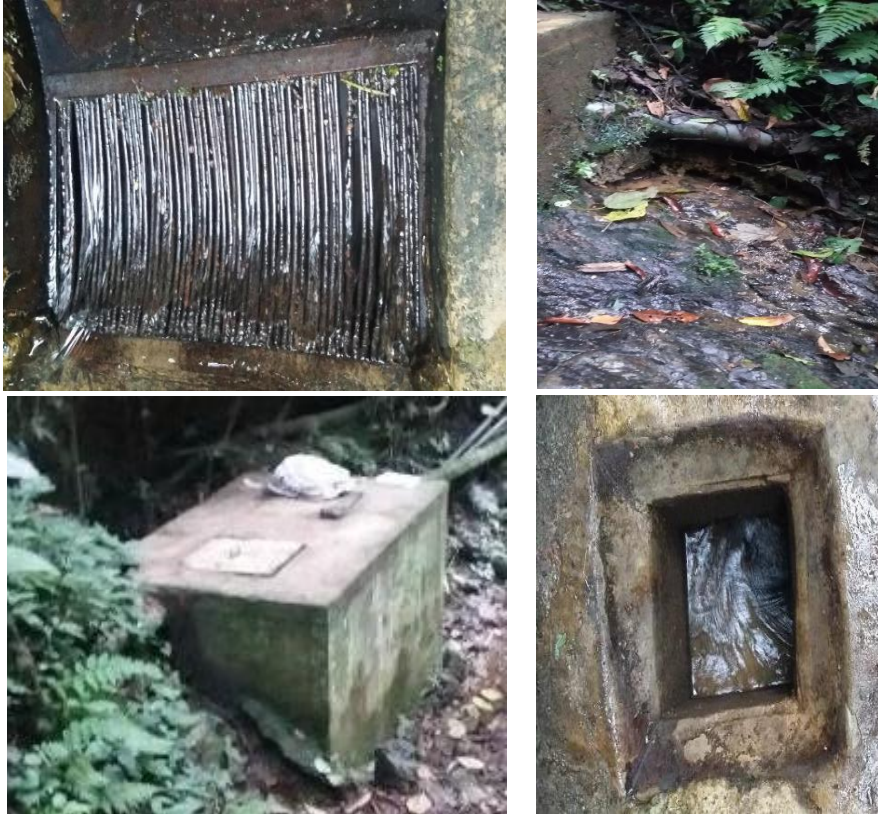
Figura 5.20. Bocatoma Y Desarenador Coordenadas N 6°7'43.2912" W 75°36'52.5132".
