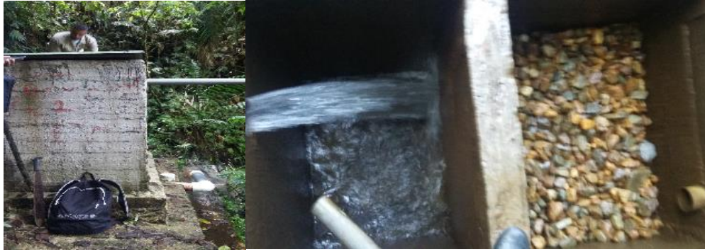
Figura 5.32. Bocatoma y filtro #2 Coordenadas N 6°7'20.4744" W 75°35'36.636"
