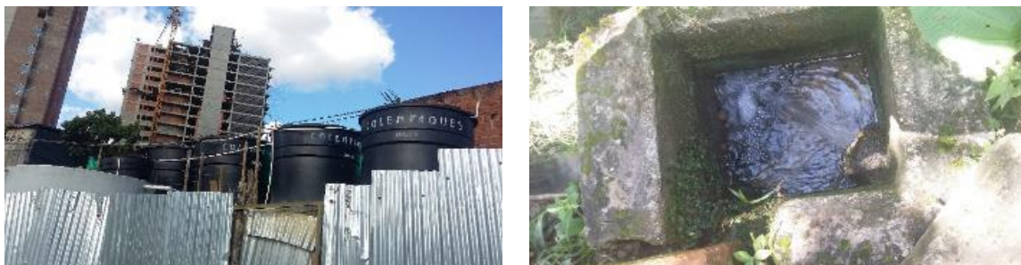
Figura 5.50. Sistema de tratamiento N 6° 8' 35.6352" W 75°36'24.9408"
