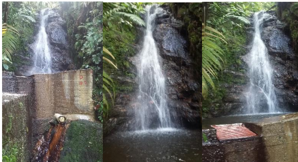
Figura 5.31. Bocatoma y filtro #2 Coordenadas N 6°7'20.4744" W 75°35'36.636"
