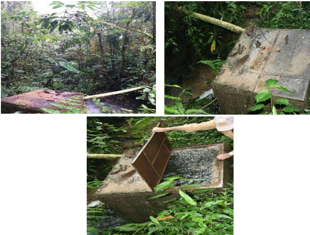
Figura 5.9. Almacenamiento del agua captada que iría directamente hasta el desarenador, este está junto a la bocatoma.
