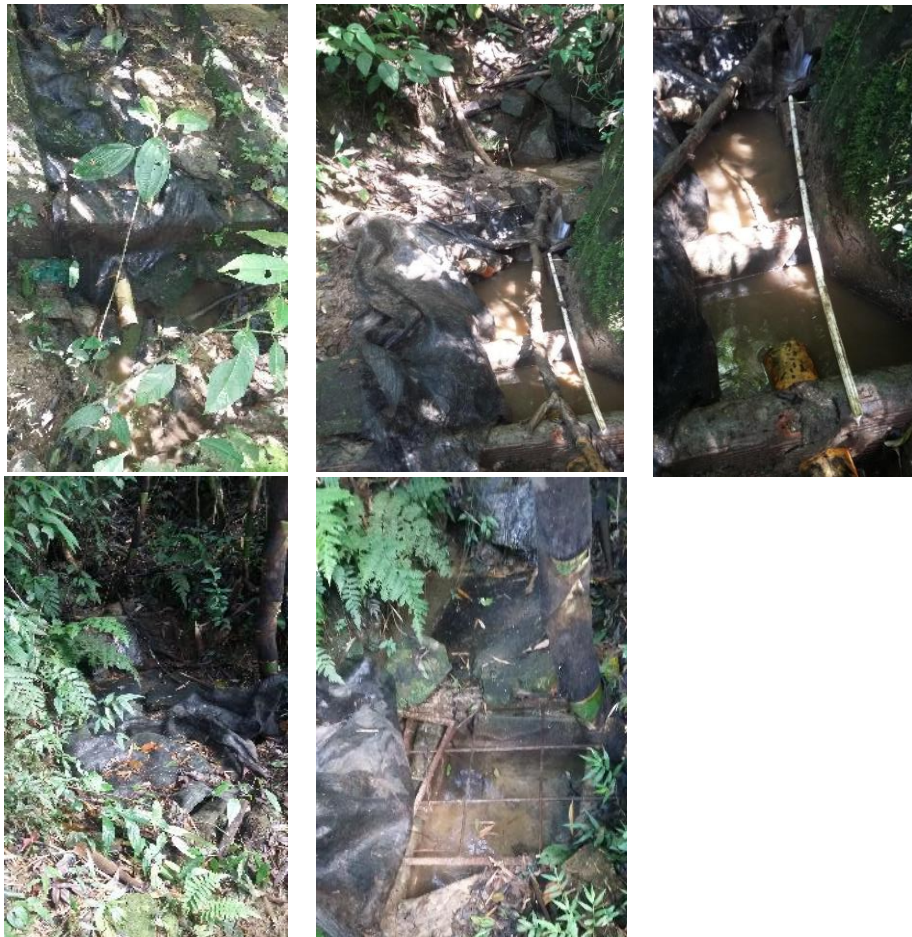
Figura 5.49. Bocatoma #3 N 6°8'27.2292" W 75°35'37.6404", bocatoma #4 N 6°8'28.3956" W 75° 35'37.3272", bocatoma #5 N 6°8'29.2236" W 75°35'37.9032"
