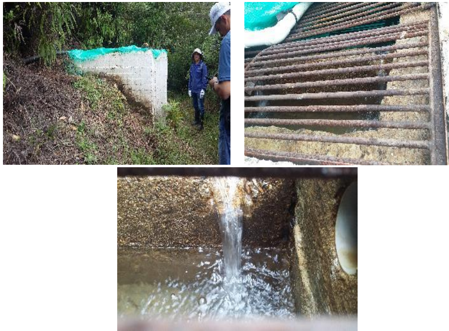
Figura 5.14. Tanque Desarenador Coordenadas N 6° 7' 53,5728" y W 75° 35' 55,7484"
