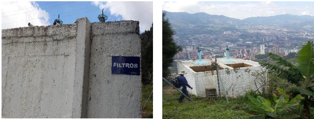
Figura 5.15. Filtros del acueducto coordenadas N 6° 8' 2,814" W 75°35'55.7484"
