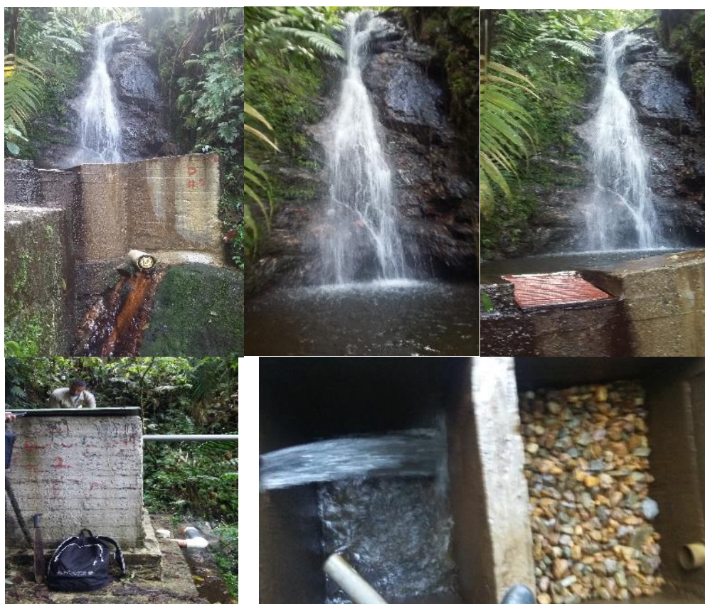
Figura 5.23. Bocatoma y filtro #2 Coordenadas N 6°7'20.4744" W 75°35'36.636"
