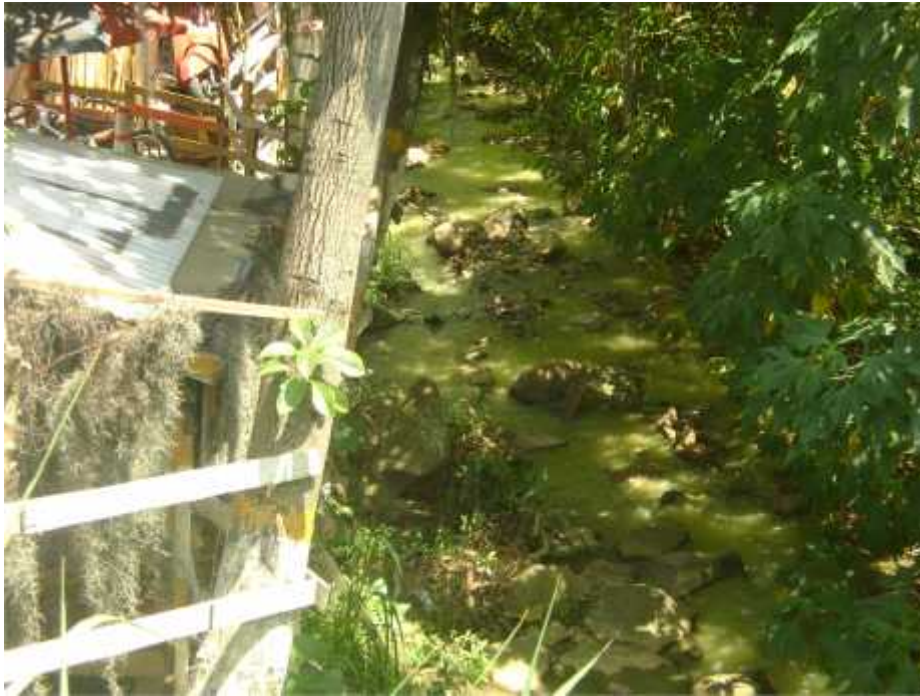
Foto 5. Quebrada La Honda teñida de verde al salir del boxculvert de la Ciudadela Industrial Sabaneta
